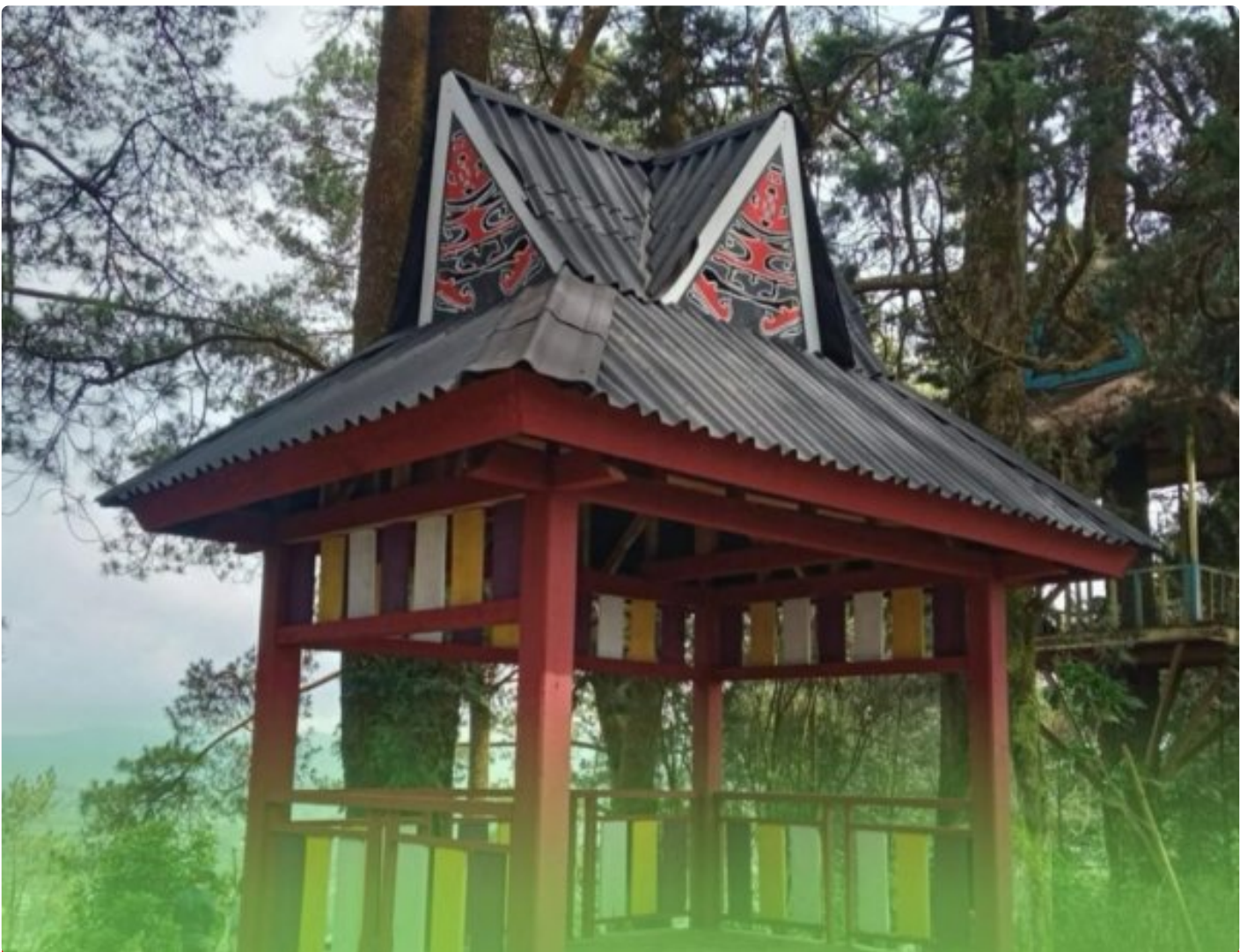
Proyek Gazebo Dinas Pariwisata Pemkab Karo TA 2022, yang sedang ditangani Poldas Sumut
